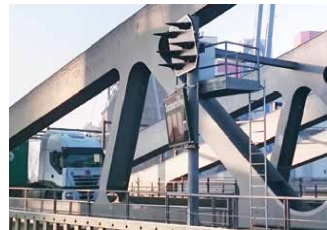
Einfahrtssignalmast Hindrik mit Brückensignaltafel Lasse und 6 Schleusensignallaternen S 145 LED
