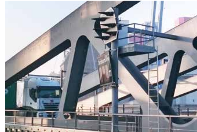
Einfahrtssignalmast Hindrik mit Brückensignaltafel Lasse und 6 Schleusensignallaternen S 145 R
