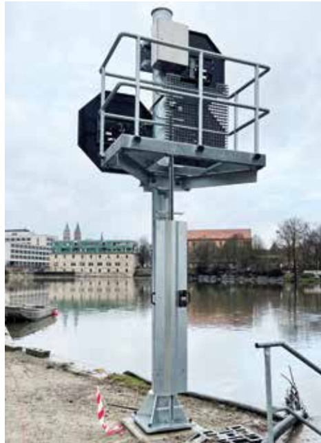
Einfahrtssignalmast Hindrik mit Schleusen- signalgruppe Julius und 5 Schleusensignal- laternen S 145 R
